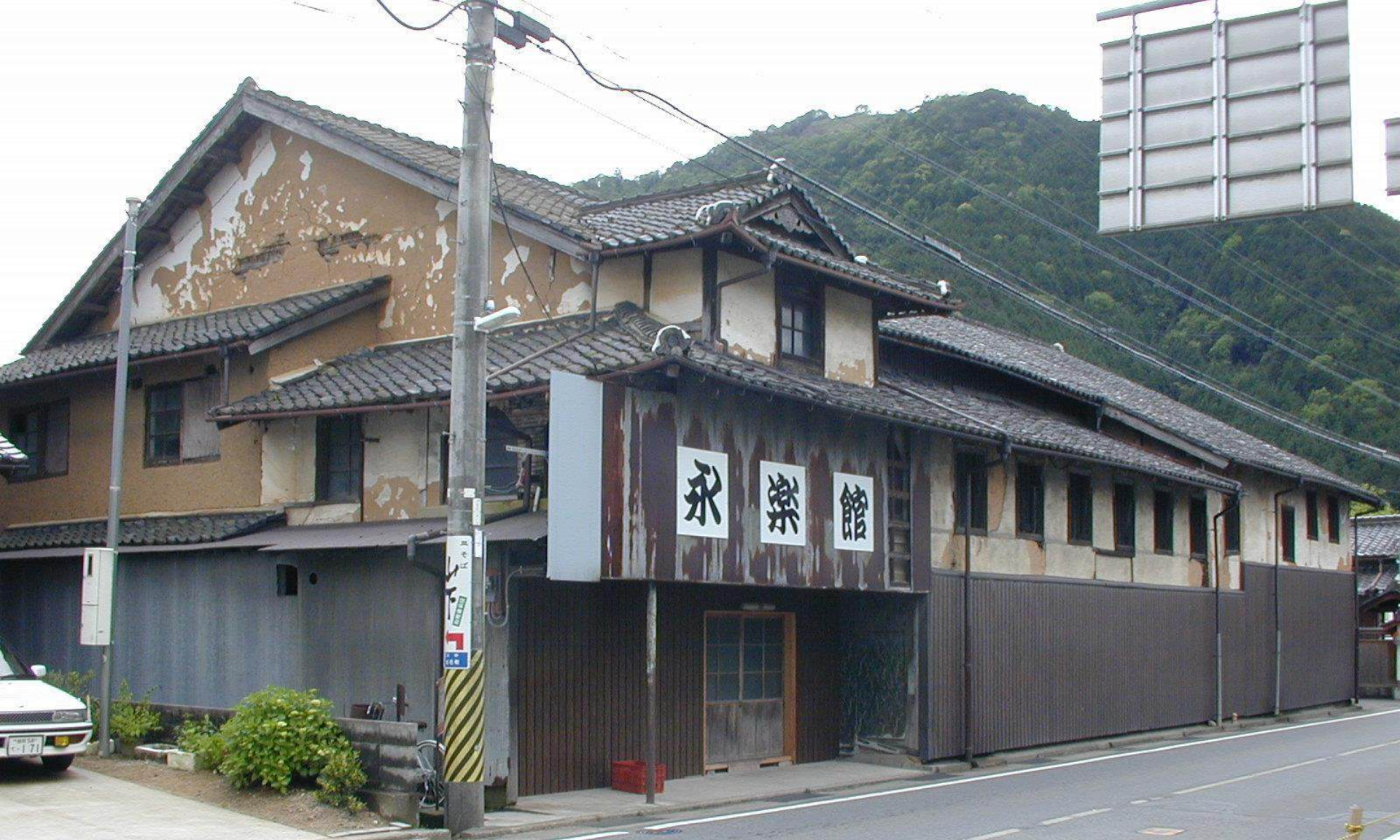
近畿に現存する最古の芝居小屋 「永楽館(1901年)」
