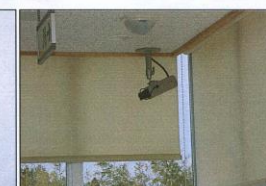
(暗内)ト々改修
