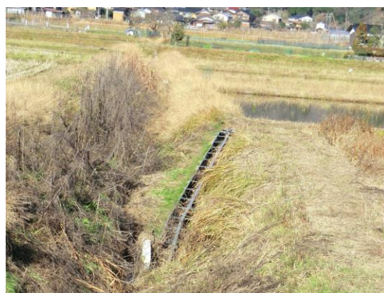
水田に設置された魚道
