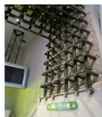
耐震性を高めるための 鉄筋コンクリート壁の実規模大模型 (日本原燃・パケ所PR館)
