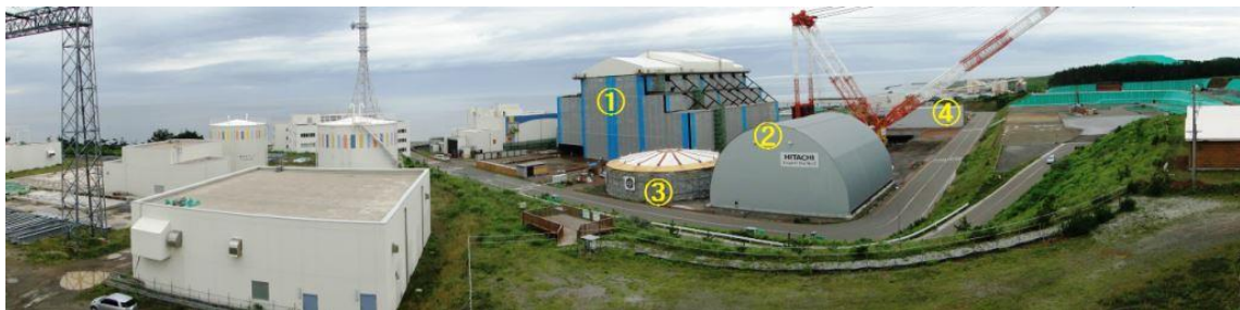
図 3 大間原子力発電所の工事状況
