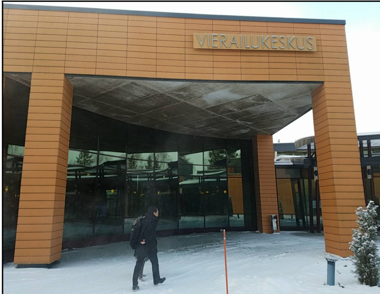
Olkiluoto Visitors Center
