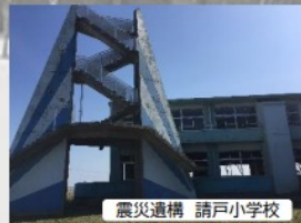
震災遺構 請戸小学校
