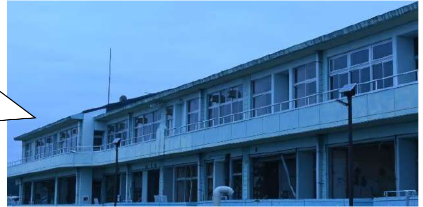
請戸小学校遺構
