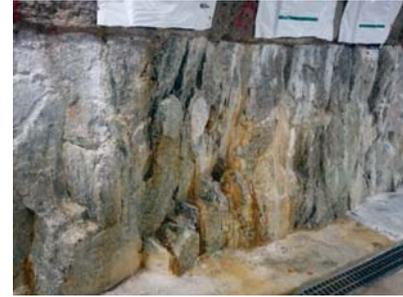
湧水している割れ目(中央部)としていない割れ目(両端)がある
