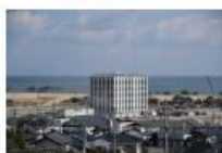
駅東地区開発の核となるビル建設中の「広野からいっしょにふたば」平成28年3月末完成
