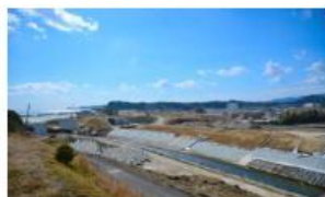
沿岸の減災を目的とし、建設中の防波堤(土壁)高上げ10m、約2年(1)
