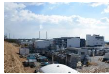
既存の工業団地（全社操業再開）
