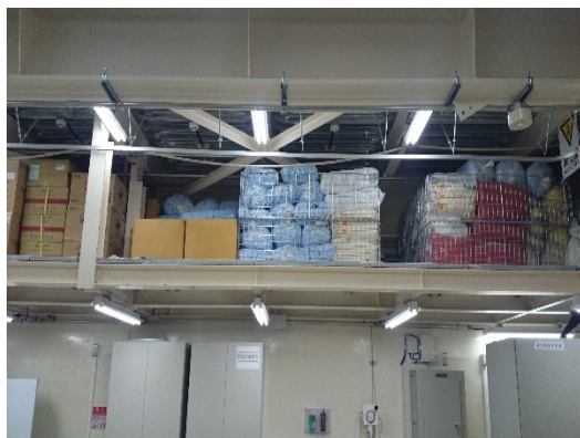
代替緊急時対策所②
