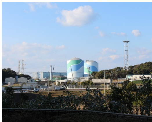
原子炉建屋（1号機，2号機）
