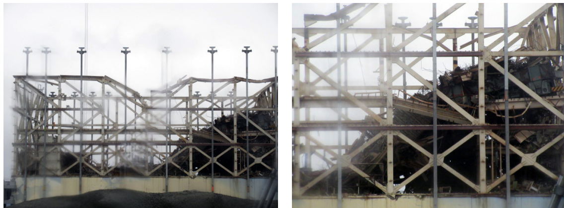
図 6 1号機建屋カバーの側柱・梁取付け状況
