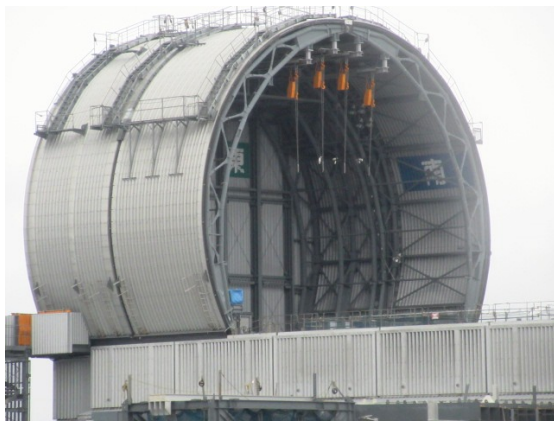
図 8 3号機のドーム屋根設置作業の状況
