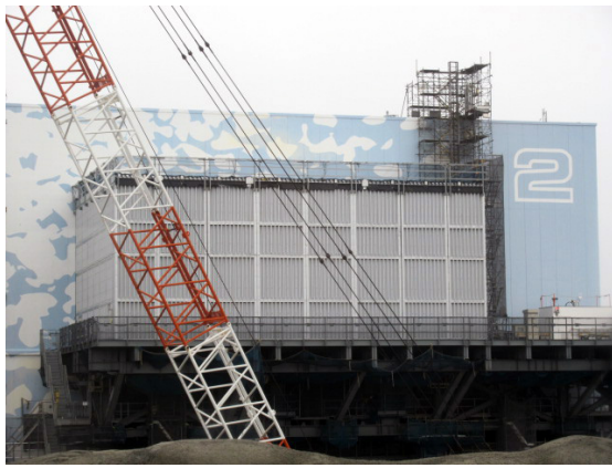
図 7 2号機のアクセス用構台と前室の設置状況
