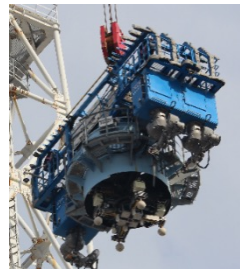
排気塔解体ロボット TOKYO
