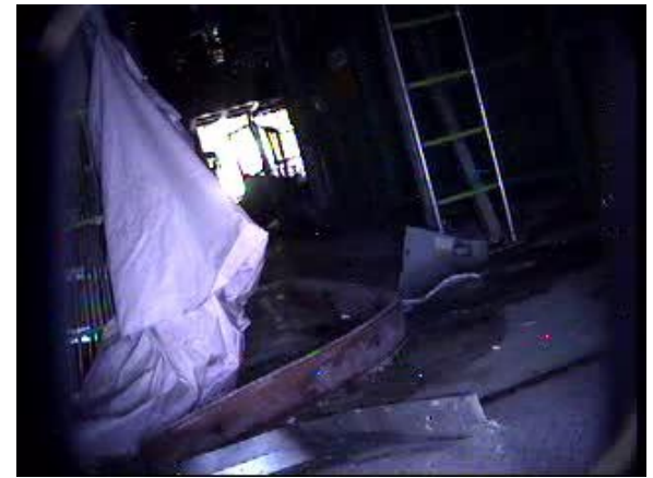
3号機原子炉建屋1階
