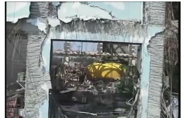
4号機東側より建屋内部
