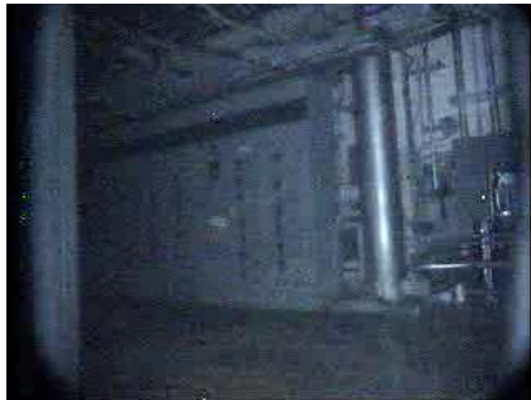
2号機原子炉建屋1階
