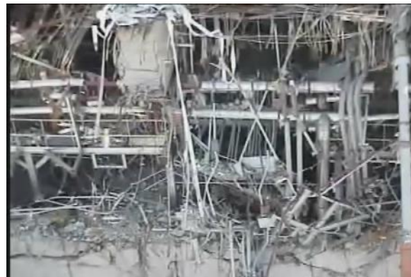
3号機西側より建屋内部
