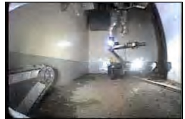
パックポットによる 原子炉建屋の現場確認
