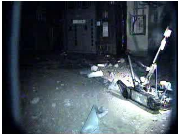
1号機原子炉建屋1階
