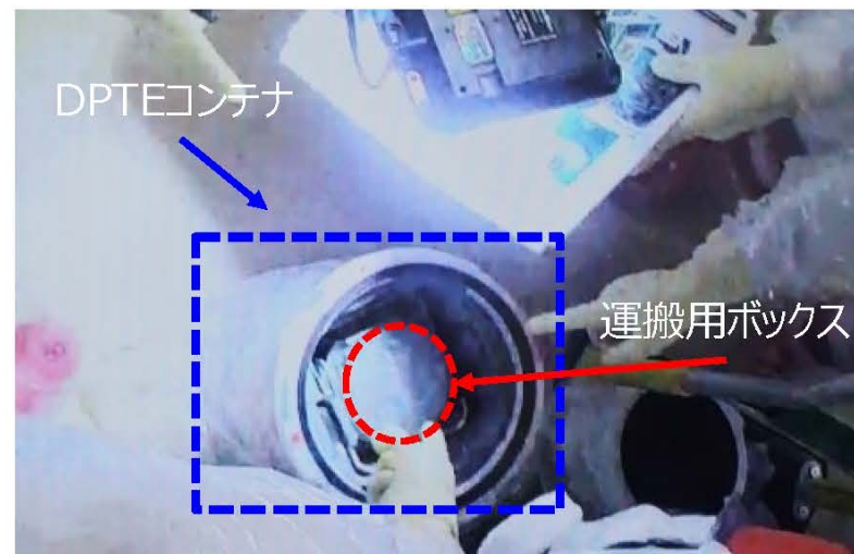
運搬用ボックスをDPTコンテナへ収納する様子 撮影：2024年11月7日
