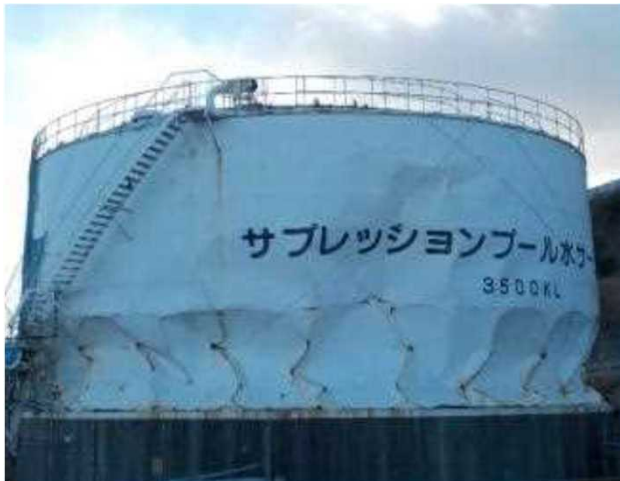
写真：5/6号機サプレッションプール水サージタンク【津波等の怖さ】
