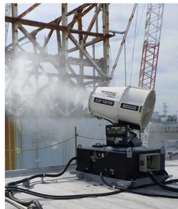
噴霧装置による散水状況
