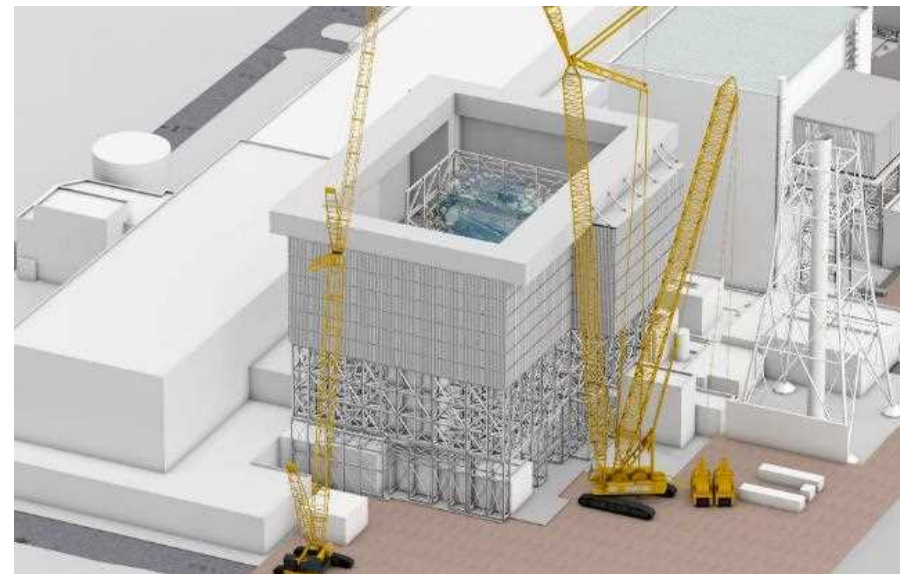
ボックスリング設置完了
