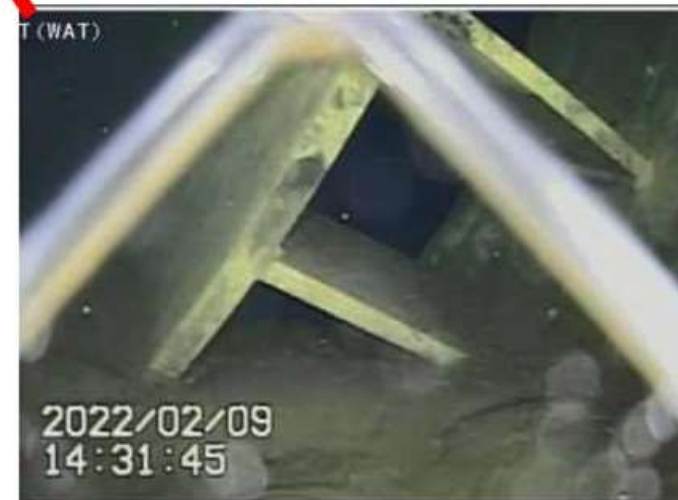
PCV東北東付近の状況 (近接)
