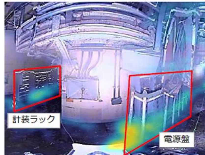
計装ラックおよび電源盤の線源 (ガンマカメラ画像)
