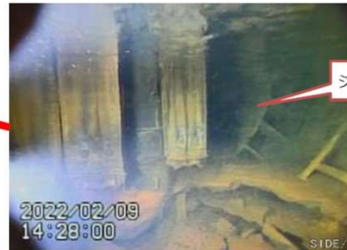
PCV東北東付近の状況(俯瞰)
