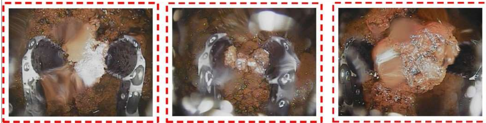
底部-1の調査状況
